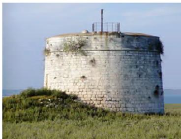
Volta ad ombrello con il piano terra cieco, senza aperture, e alloggio guardie al piano primo con feritoie e finestre. L'accesso al piano primo in origine avveniva con un ponte levatoio, mentre dal primo piano si raggiunge la piattaforma sommitale tramite una scala interna.
