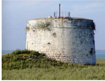
Volta ad ombrello con il piano terra cieco, senza aperture, e alloggio guardie al piano primo con feritoie e finestre. L'accesso al piano primo in origine avveniva con un ponte levatoio, mentre dal primo piano si raggiunge la piattaforma sommitale tramite una scala interna. E' uno dei monumenti meglio conservati ed in buono stato nel territorio priolese.
