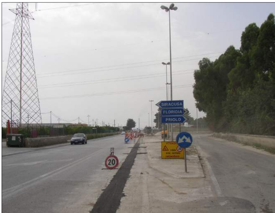
Lavori sulla ex SS114, Litoranea Priolese.
