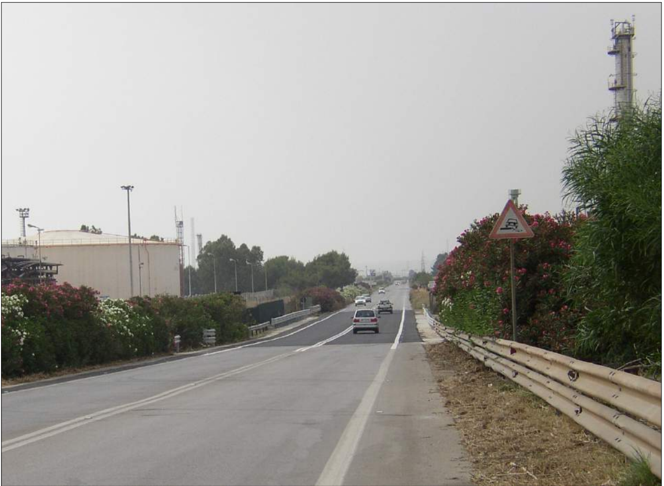
Tratto della ex SS114 riaperta dopo l'incendio del 30 aprile 2006.
