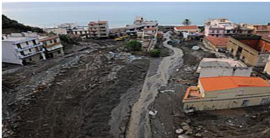
La frana di Scaletta Zanclea, comune del messinese
